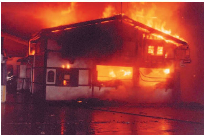
Brand einer Wirtsbude auf dem Oktoberfest. Solche Feuer sind sehr medienwirksam. Wirksame Löschmaßnahmen sind nur noch sehr begrenzt möglich. Umfassende Maßnahmen im Bereich des Vorbeugenden Brand- und Gefahrenschutzes sind deswegen zwingend notwendig, um Personenschäden zu vermeiden. Das Oktoberfest stellt jedes Jahr erneut eine besondere Herausforderung für die Mitarbeiter der Abteilung Vorbeugender Brand- und Gefahrenschutz dar. Dabei stehen die nachhaltige Qualität, mit der die Abnahmen durchgeführt werden, und die lückenlose Dokumentation der Abnahmen im Mittelpunkt.
